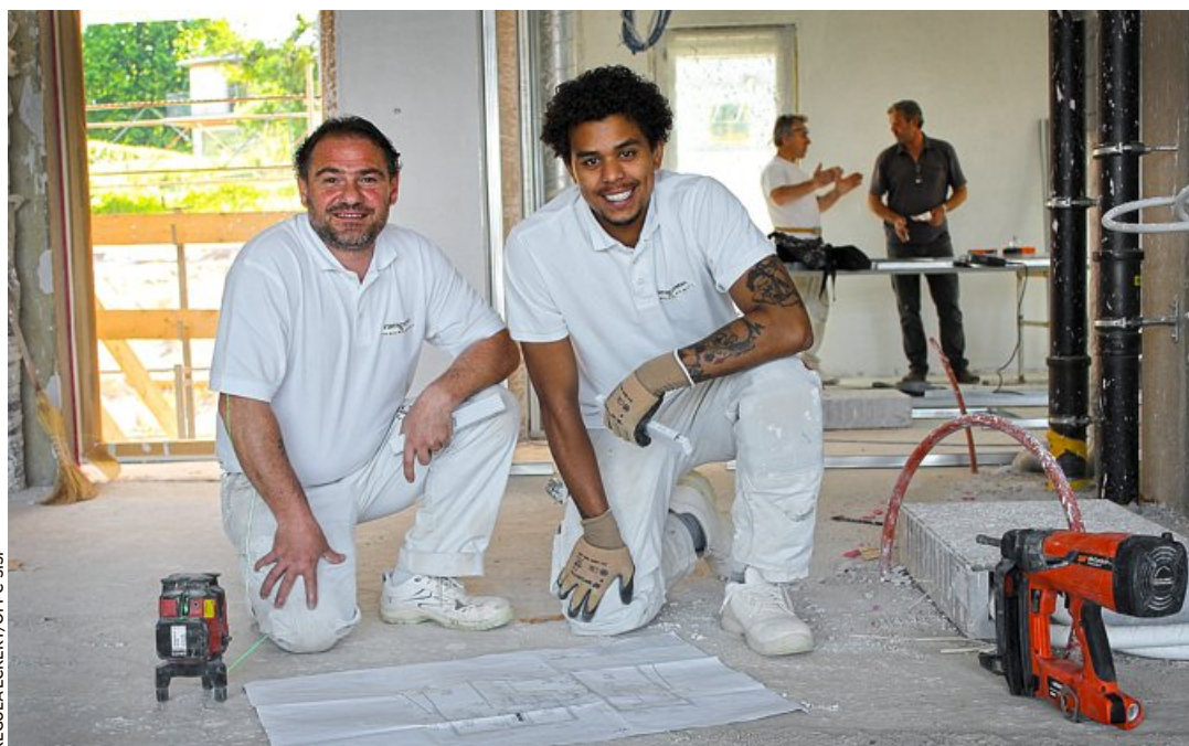
Michael Rodrigues (à droite), apprenti plâtrier constructeur à sec de 3 e année et son formateur Gianluca Cianciulli relèvent les emplacements des parois et des cloisons d'un appartement.
